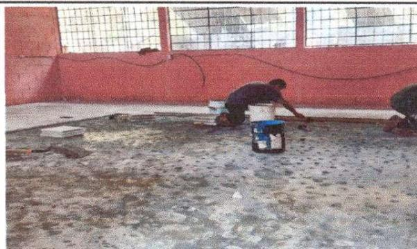
FOTO 2: pegando piso de granito en 2 salones de clase con medidas 7.35x8 metros por deterioro
