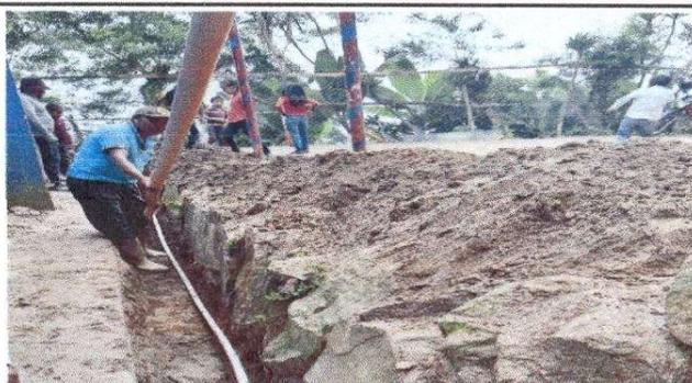
FOTO 5: Sustitución de tuberías de drenaje por deterioro.
