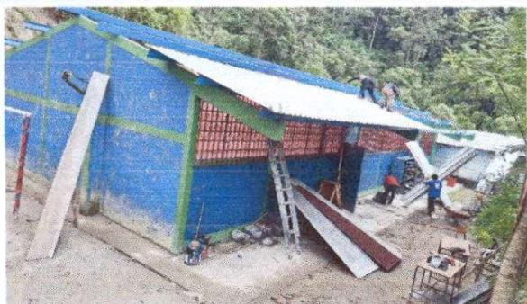
FOTO 1: Instalando láminas troqueladas de calibre 26 en el techo de la escuela por orificios.
