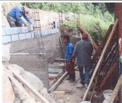
FOTO 3: Sustituyendo estructura de baños de madera por estructura de block.
